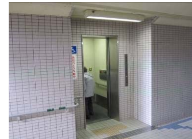
東西連絡地下通路エレベーター
