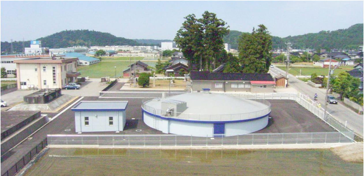
増設した中区(ちゅうく)配水池と横枕浄水場
