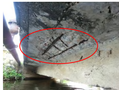
コンクリート床版の鉄筋露出 (供用年数 38 年)
