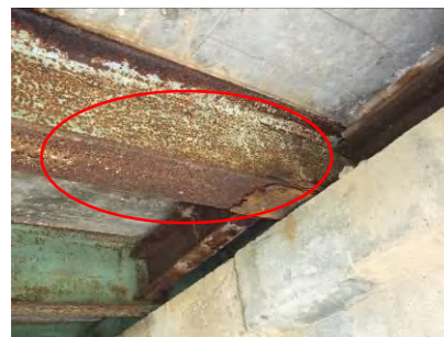
鋼桁の腐食 (供用年数 48 年)
