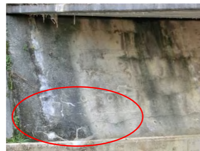
橋台のひびわれ・遊離石灰 (供用年数 32 年)
