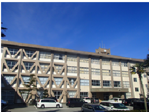
学校の耐震補強状況（東部中学校）
