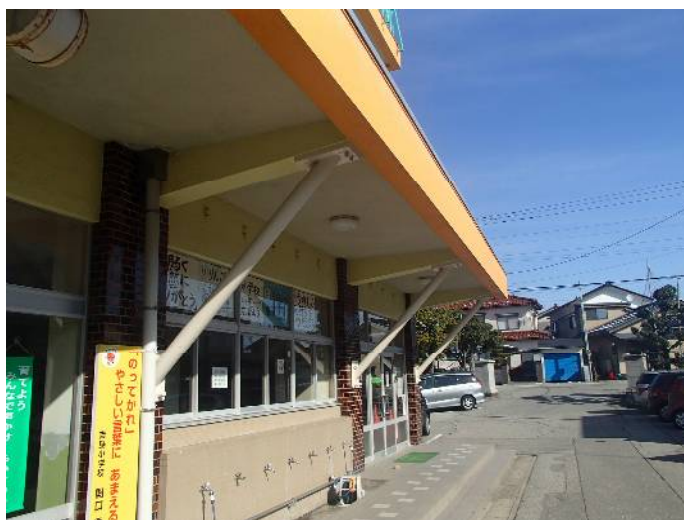
◆ 非構造部材の耐震化 ◆ ～ 吉島小学校 ～
