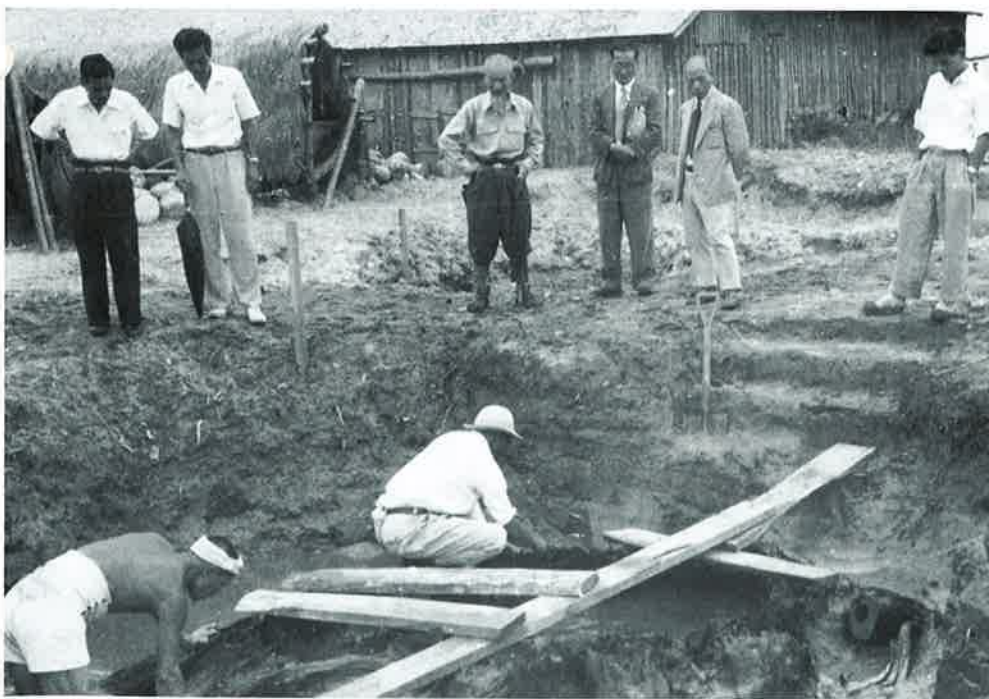
水中保存館建設のための発掘調査
