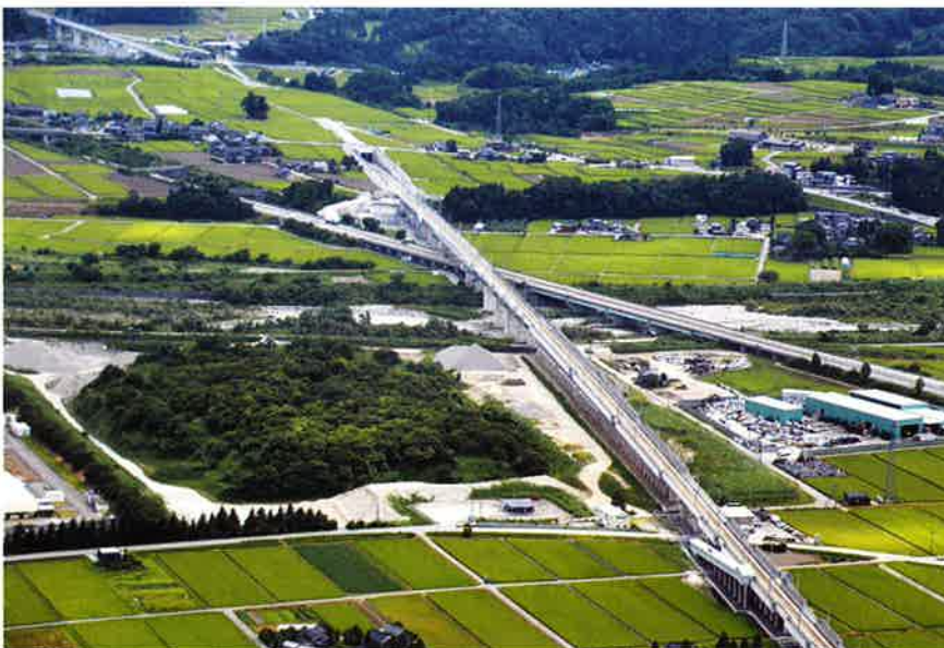
空から見た同地点(逆方向から)
