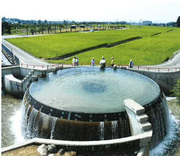
現在の天神野用水の起点、東山円筒分水
