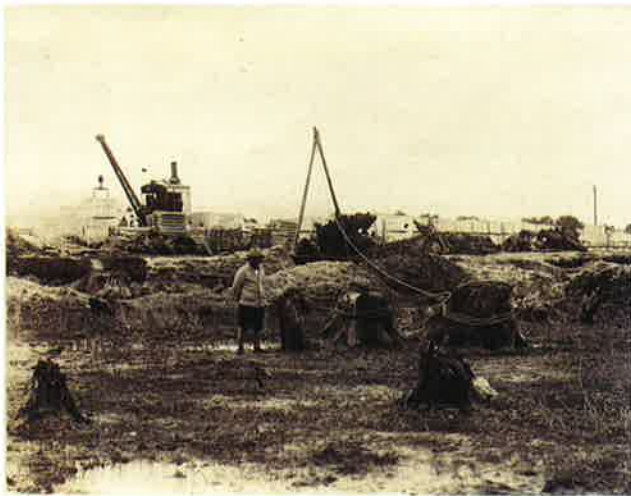
魚津港建設現場での埋没林
