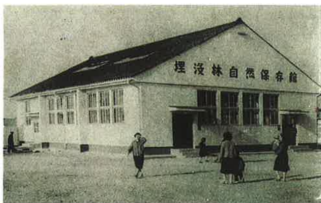
完成直後の「埋没林自然保存館」
