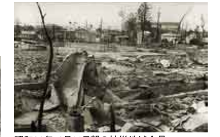
昭和31年・9月11日朝の被災地地獄全景 焼け跡
