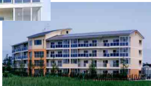
図3.5 太陽光発電システムの導入事例（富山県黒部市公共賃貸住宅）
