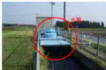
水車設置後の様子
