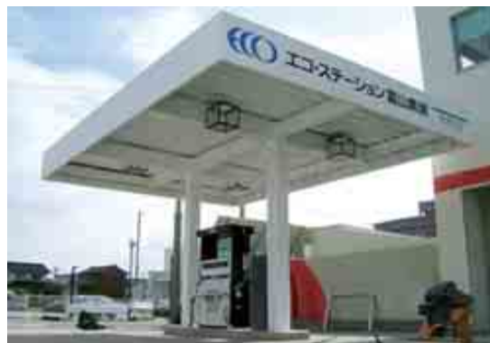
富山市内エコ・ステーション (天然ガス充填設備)
