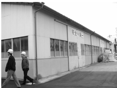
(a)ペレット製造プラント建屋
