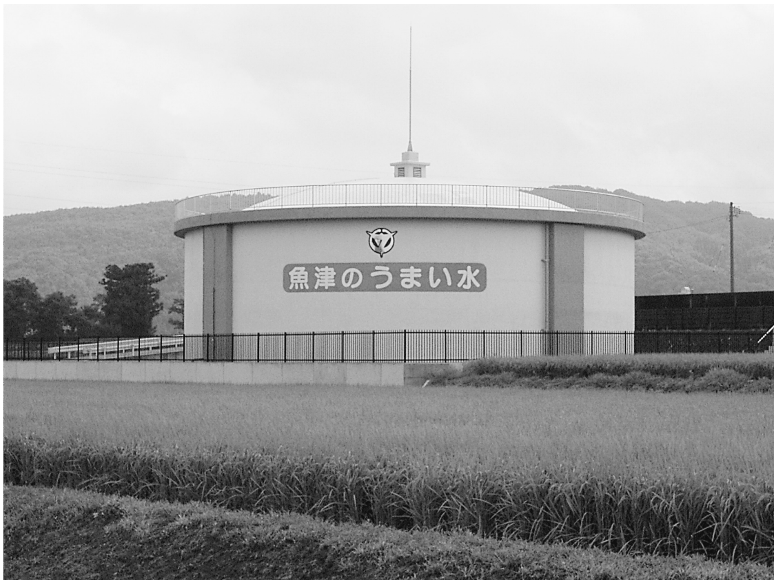
高区第1配水池（増設分）
