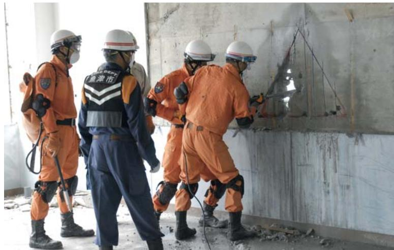
▲鉄筋コンクリートの壁に救助隊の進入口となる穴を開ける消防署員。
