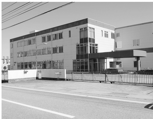
▲ 日立ツール跡地（川縁地内）
