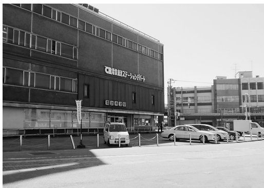
▲ 整備計画が予定されている電鉄魚津駅及び駅前広場
