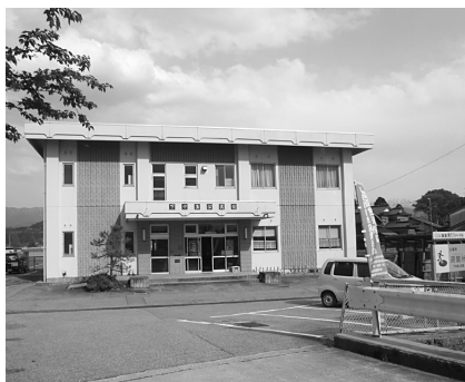
▲ 大規模改修予定の下中島公民館
