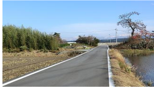
片貝川 かすみ堤 持光寺地内
