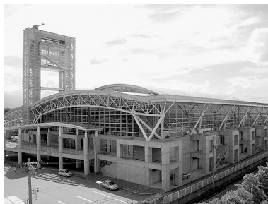
▲ 修繕予定のありそドーム
