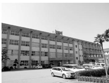
▲ 耐震補強工事を行う 東部中学校校舎
