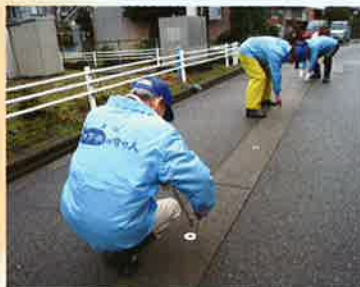
散水ノズルの点検
