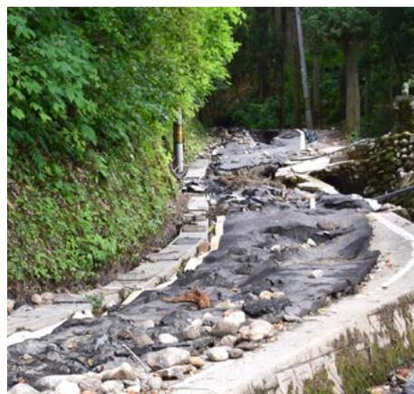
▲地盤が緩み、道路のアスファルトが変形(日尾)
