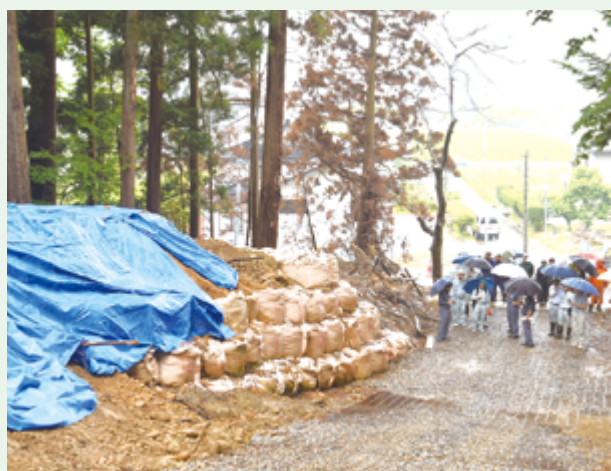
▲土砂崩れで東山神社が崩壊した現場の復旧工事を視察
