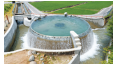
改修された東山円筒分水槽
