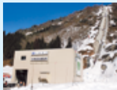
建設中の片貝別又発電所
