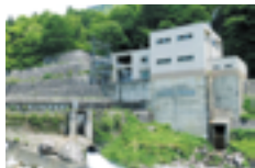
片貝東又発電所
