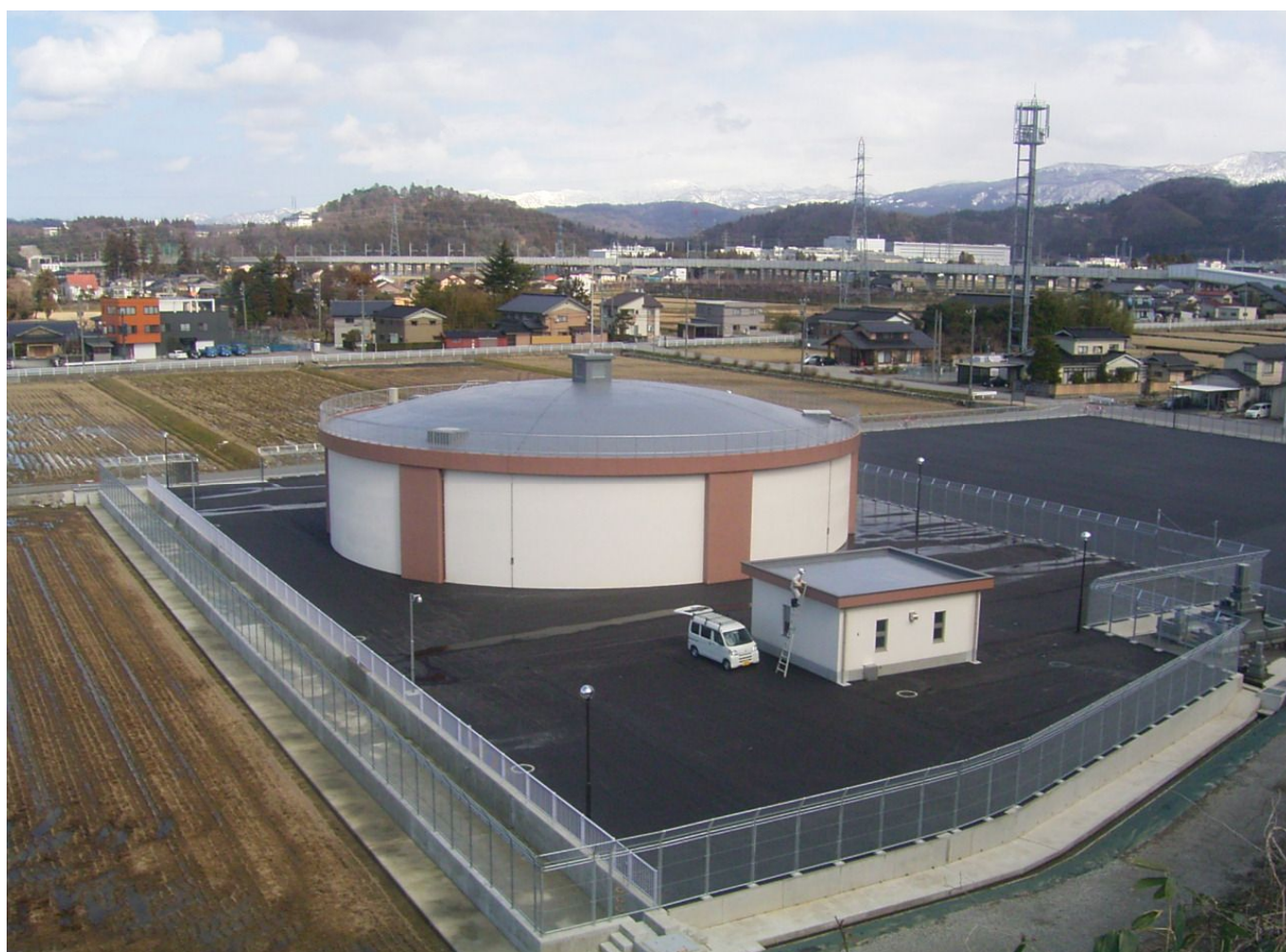
六郎丸低区配水池
