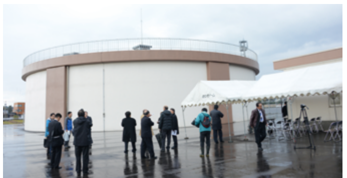
六郎丸低区配水池
