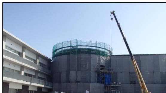
建設中の校舎（2月20日現在）
