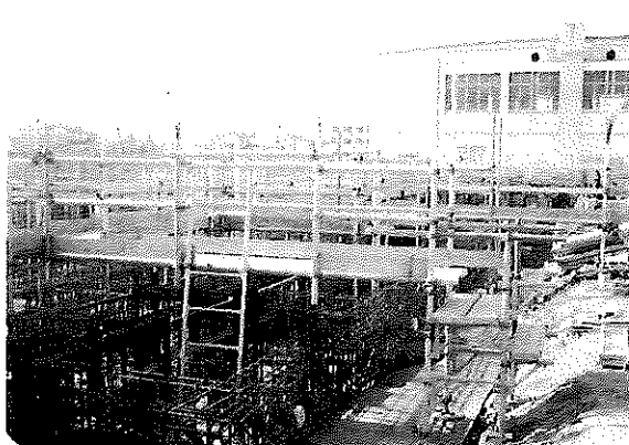
住吉・上中島・松倉統合小学校 建設状況（12月下旬）
