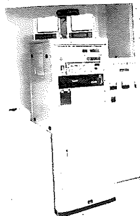
■手動操作パネル(親局設備)
