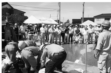
水道管復旧訓練
