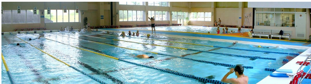
現在の温水プール内部の状況
