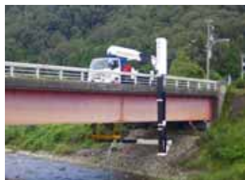
(橋梁下面の点検状況)
