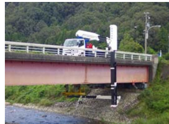
(橋梁下面の点検状況)
