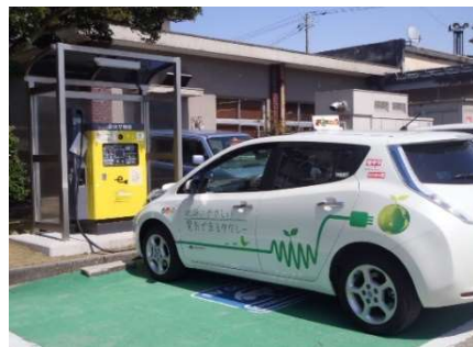
電気自動車急速充電器と 電気自動車
