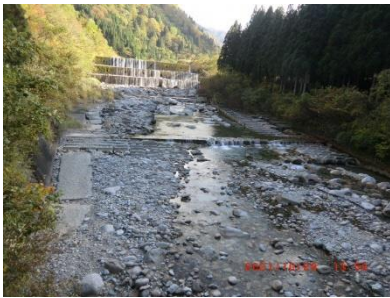
キャンプ上流の砂防堰堤 (3段堰堤は珍しい)
