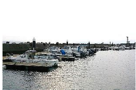
経田漁港 （レジャーボート係留施設）
