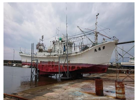
老朽化している漁船保全修理施設
