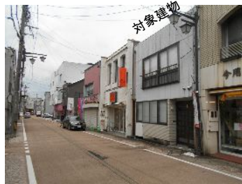
建物前の通り
