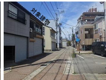
建物前の通り
