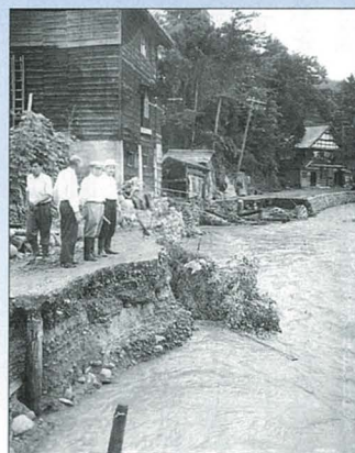
昭和27年7月。ここ魚津でも大水害が発生し、多大な被害が出ました。
