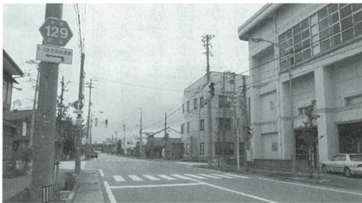
写真は村木小学校前交差点から工事区間を撮影
