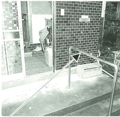
段差のある玄関に入る時に転ばないための手すり。
