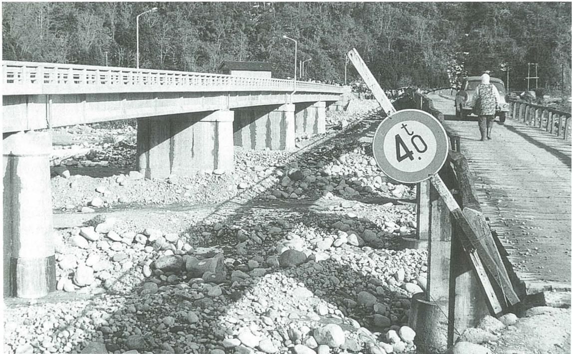
写真は昭和41年11月、完成したばかりの入会橋(写真左)を滑川側から撮影している。当時早月川はたびたび大水に見舞われ、旧橋(写真右)の橋げたも一部流失。1年前から新橋の建設が進められていた。
