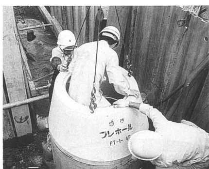
着々と進む下水道事業(マンホール設置作業)
