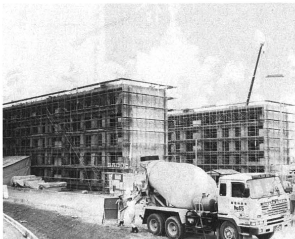
雇用促進住宅建設工事
