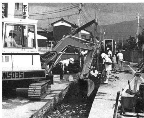
急ピッチで進む下水管の布設工事
