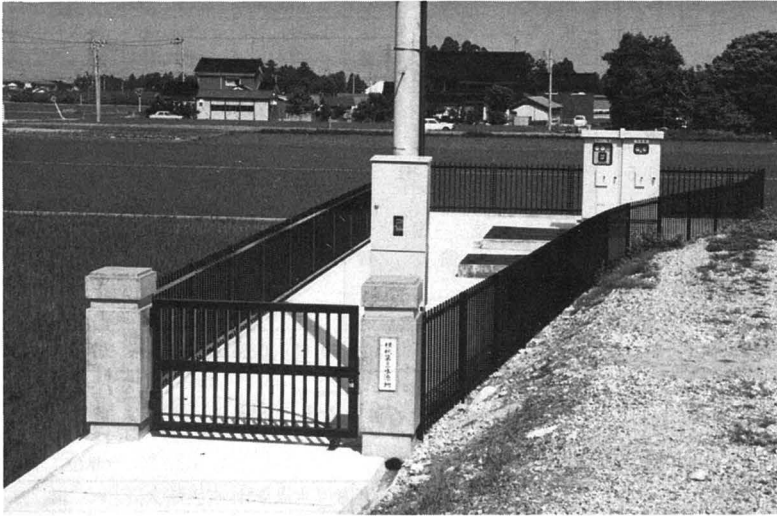
▲横枕第3水源池
