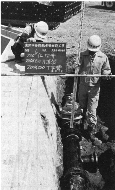
魚津中央線配水管布設工事
