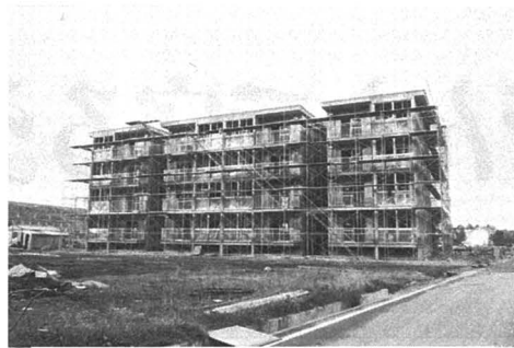
▲建設中の市営住宅
