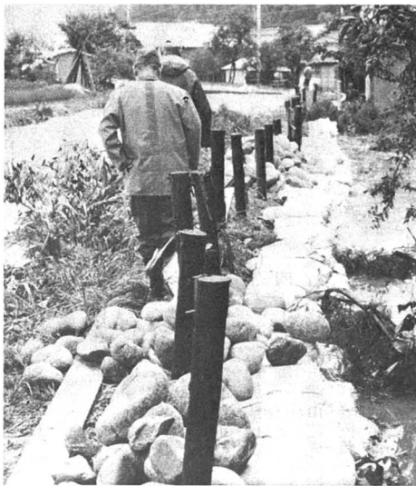
▲必死の作業で欠壊を免る（蛇田地区内）
