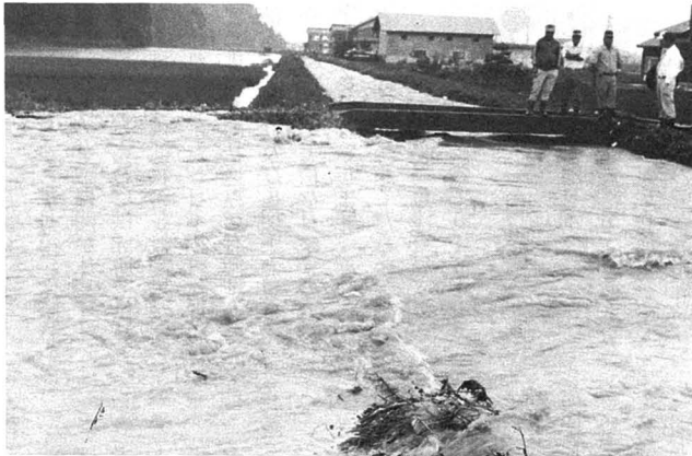
▶堤防が欠壊して流れ込む濁流（小川寺地区内）
