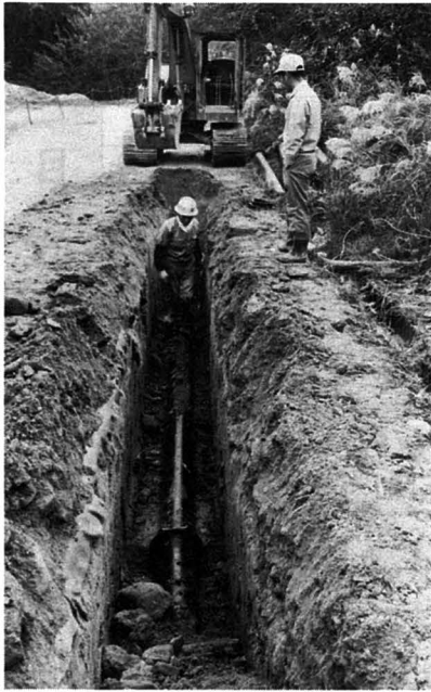
▲ 配水管布設工事
