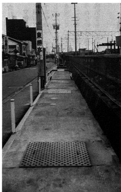
▲新設された自転車置き場
