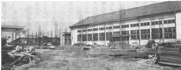
▲大町小学校危険改築工事
