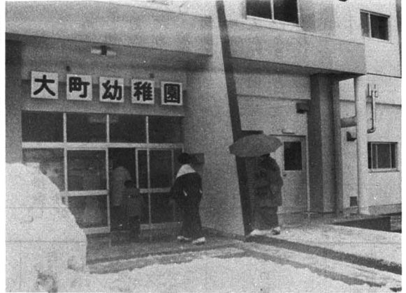
▶完成した大町幼稚園
